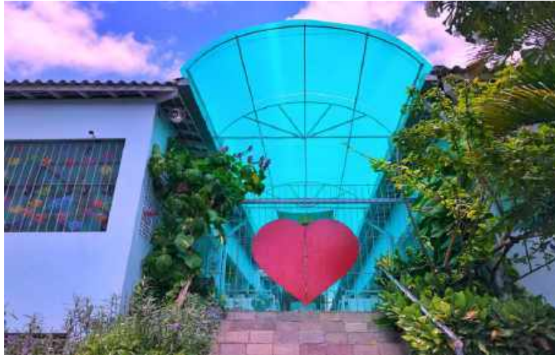
改修された屋根
